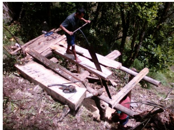
Ein „Sägewerk“ in Nepal: Vorbereitungen für den Bau des Schulgebäudes
